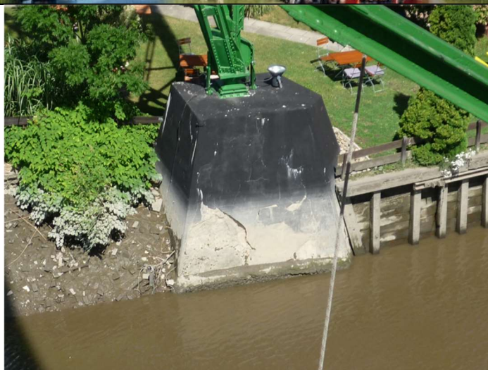
Fotobeispiel eines Fundaments aus der Fern-...
